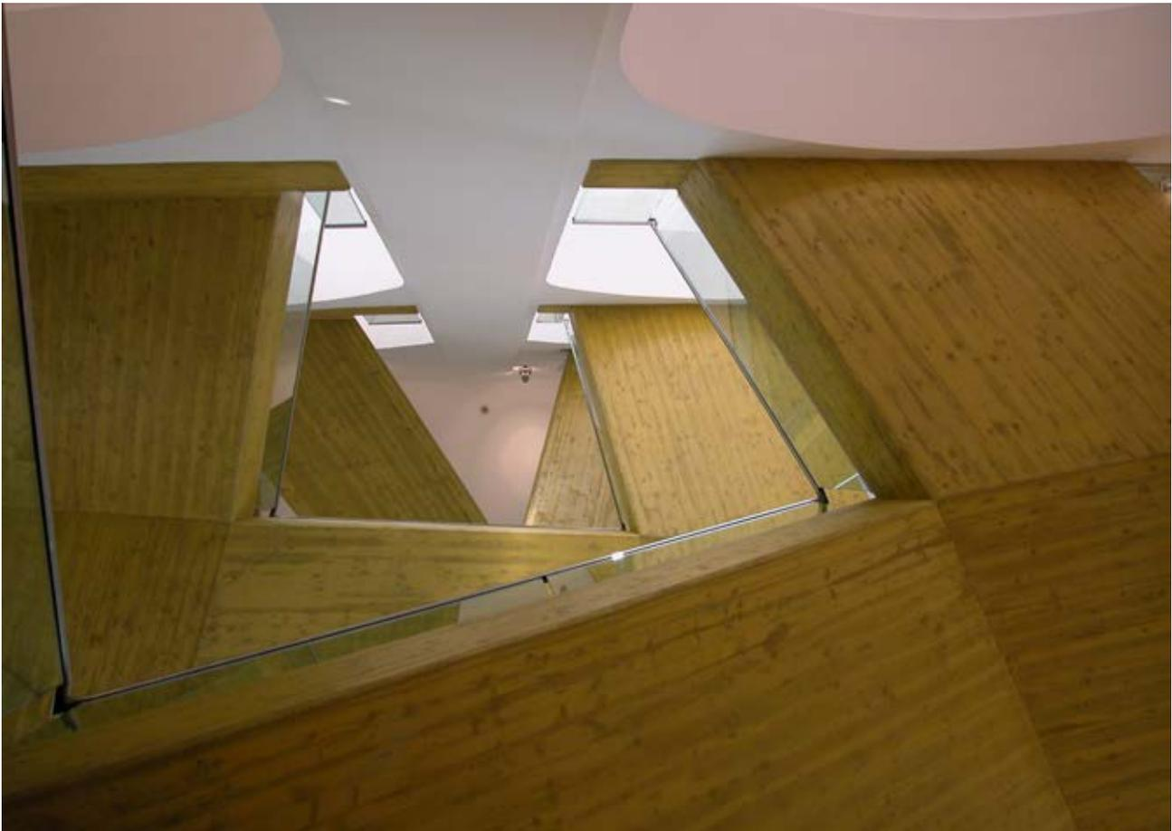
Abb. 5: Alt und Neu im Stift Melk: Die neue Stiege im barocken Kolomantrakt in eingefärbtem schalreinen Beton, ausgeführt 2004/05 nach Plänen von Wehdorn Architekten ZT GmbH. Statement Manfred Wehdorn: Oft ist es weniger die Frage nach Alt oder Neu, sondern die Frage nach Qualität, die entscheidend ist © Brigitte Kobler
