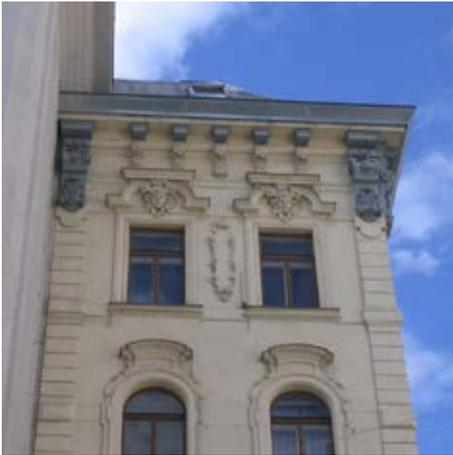
Abb. 16a (links) und 16b (rechts): Die obersten Profile von Gesimsen (Sima), sowie die Verkleidung der Eisenträger größerer Konsolen hat man aus Zinkblech hergestellt und danach durch die Färbelung mit den übrigen Elementen aus Stuck etc. zu einer Einheit zusammengeführt. (siehe Abb. 16b) Im Gegensatz dazu hat man im Fall Abb. 16a die Blechteile verständnislos blechfarben beschichtet. .
