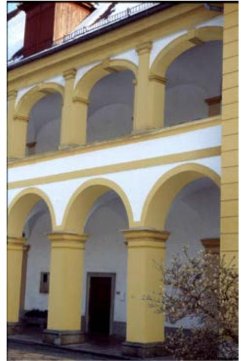
Abb. 19a (links) und 19b (rechts): Eine Arkade mit „Farbauflagen“ an der Außenseite der Bögen. Die Farbe soll immer einen Baukörper betonen. Daher darf ein Farbwechsel nie an einer Außenkante liegen (Abb. 18a). Da man mit der Farbverteilung den tektonischen Aufbau unterstreichen sollte, müsste die Farbverteilung der Abb. 18b entsprechen.
