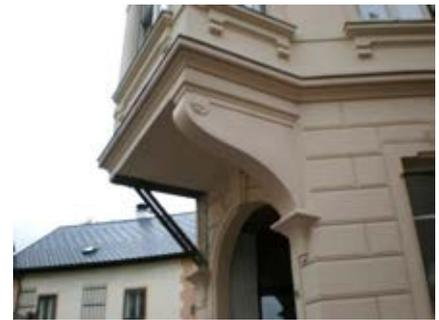
17b (rechts): Ein Balkon bei dem der Aufbau eines LKWs eine Konsolenverkleidung heruntergerissen hat.
