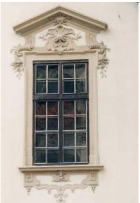
Abb. 13a (links) und 13b (rechts): Oft liegen Partien eines Gestaltungselements, wie hier bei der Verdachung des Fensters und bei der Schabracke unter der Sohlbank, in der Wandebene. Wenn Teile dieser Gestaltungselemente in der Nullfläche liegen und deshalb deren Farbe erhalten, werden sie zum Loch und die erhabenen Teile zu sinnlosen, unmöglichen Bändern. Fotos: Friedmund Hueber
