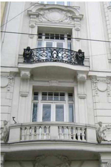
Abb. 18a (links) und 18b (rechts): In der Fortsetzung steinerner Balkonbrüstungen wurden in dem Geschoß darüber die Brüstungen aus Schmiedeeisen hergestellt, um sie leichter und luftiger erscheinen zu lassen. Das Eisen (siehe Abb. 18a) ist in der Tradition des Dorfschmiedes durch Schwarzfärbeln störend aus der Gesamtkomposition gerissen worden. Auch eiserne Gitter saßen nie wie Fremdkörper in der Architektur, sondern waren Teil der jeweils einfarbigen oder bunten Gestaltung, wie Abb. 18b zeigt.
