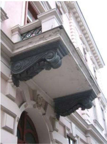
Abb. 17a (links): Auch die gestalterisch notwendigen großen Konsolen unter Balkonen erhielten ihre Form durch eine Verkleidung aus leichtem, exakt formbarem Zinkblech, das hier fälschlich materialfarben gefasst wurde.
