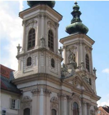
Abb. 12a1 (links): Durch die Farbe der Nullfläche auf den Friesen im Hauptgebälk und in den Gebälken der Türme fehlt den Gesimsen das Auflager. Auch das Tympanonfeld im zentralen Giebel müsste die Farbe der Architektur und nicht jene der Nullfläche tragen. Foto: Friedmund Hueber
